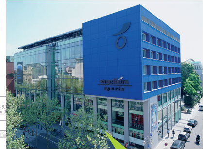
Umbau und Aufstockung, Sporthaus Engelhorn
