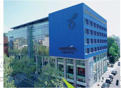
Umbau und Aufstockung, Sporthaus Engelhorn
