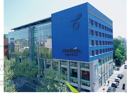
Umbau und Aufstockung, Sporthaus Engelhorn
