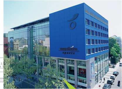
Umbau und Aufstockung, Sporthaus Engelhorn
