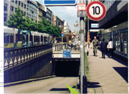
Unterirdische Zufahrtsrampe NI, Mannheim
