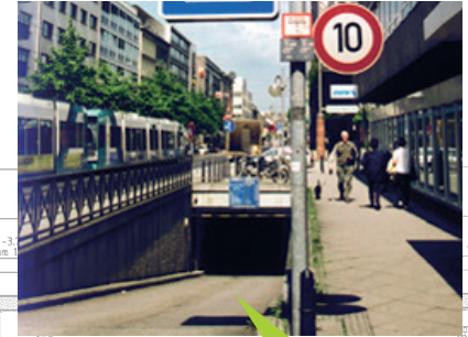
Unterirdische Zufahrtsrampe NI, Mannheim
