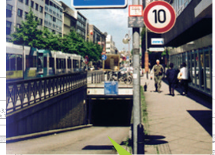
Unterirdische Zufahrtsrampe NI, Mannheim
