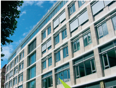
VR Bank Rhein-Neckar, Augustaanlage Mannheim
