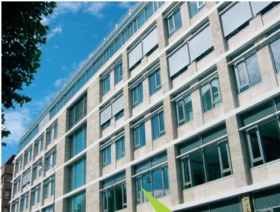
VR Bank Rhein-Neckar, Augustaanlage Mannheim
