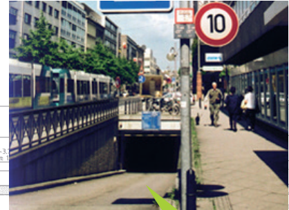
Unterirdische Zufahrtsrampe NI, Mannheim
