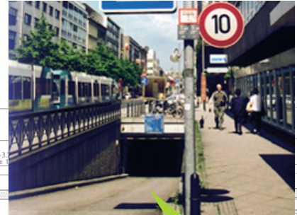
Unterirdische Zufahrtsrampe NI, Mannheim
