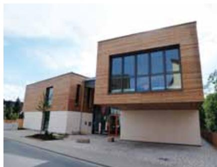
Die Rückhängung der Lasten aus den auskragenden Obergeschossflächen wurde mit zwei auskragenden parallelen Außenwandscheiben und zwischenliegender Geschossdecke realisiert.
